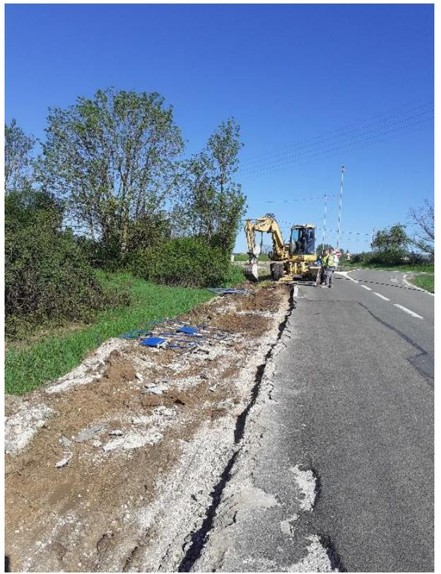
Il était urgent de remettre en état la chaussée au niveau du carrefour de la route du château d'eau avec la sortie de la méthanisation. C'est chose faite avec l'intervention de l'entreprise SEFP d'Abergement-la-Ronce qui a su consolider les lieux avec la pose de bordures béton et la réalisation d'un trottoir prolongeant en direction du village, la voie partagée de l'avenue Eisenhower.
